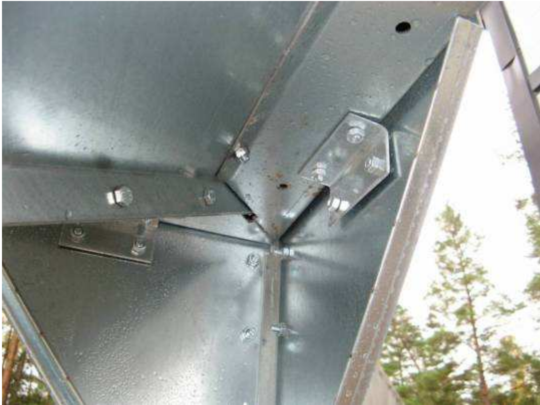
Kuva kulmaan tulevasta kartiojalan kiinnityksestä sisäpuolelta. Kulmajalka kiinnitetään kartion tukipaloihin, sormipiukkuudelle
