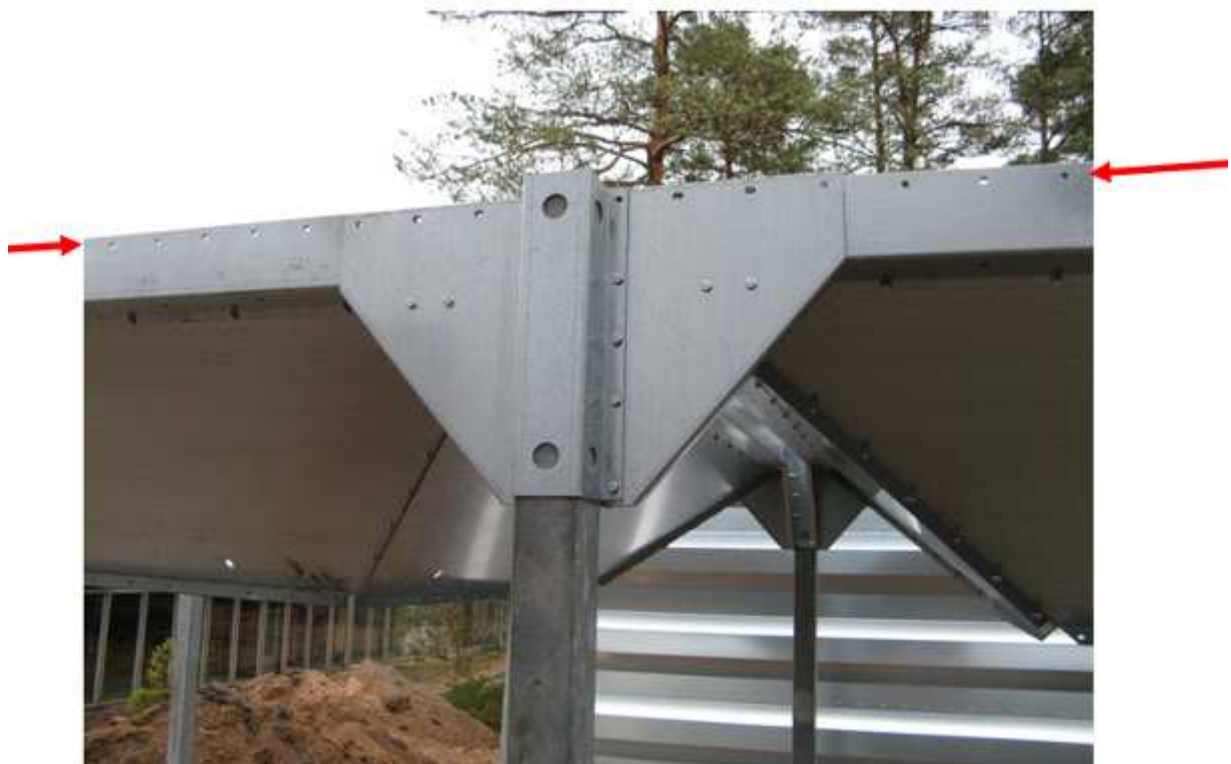
Kuva ulkopuolelta keskijalan kiinnityksestä kartioihin. Nuolet osoittavat yläriiviä, joka jätetään ilman pultteja asennuksen helpottamiseksi.
