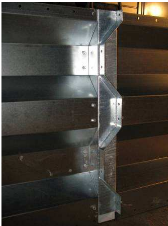
Kuvassa keskellä tolppa (3V) ja kaksi ulkoseinämää sisäpuolelta katsottuna.
