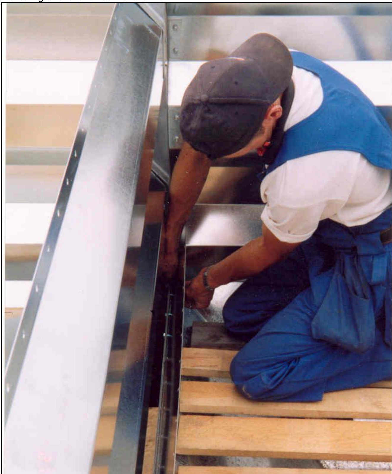
Montering av silokonernas mellanskiva
