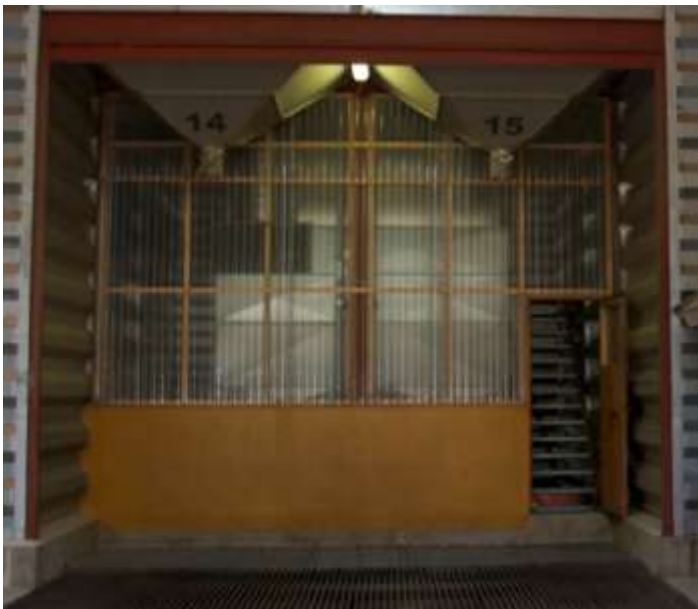
Valokate kaatosuppilon takaseinänä
