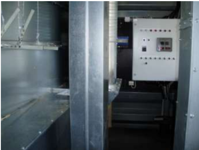
Elevaattorin välissäkin on tilaa
