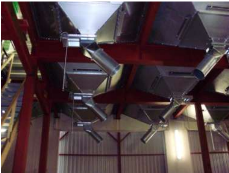
Veitsisuljin ketjupyörällä saatavuus: 200mm ja 250mm myös moottoroituna
