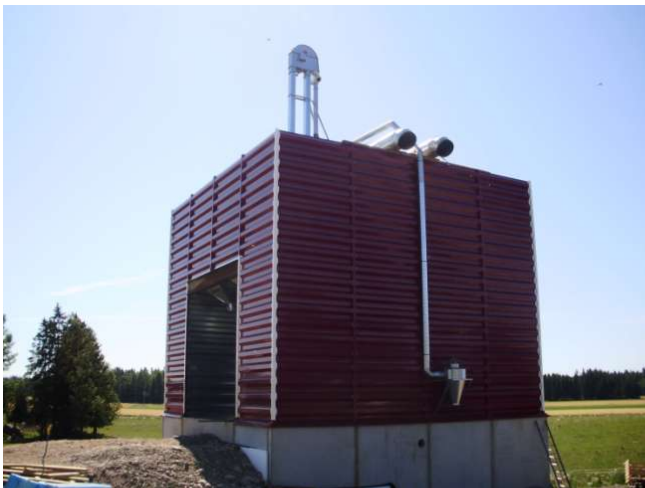
Sykloonin asennus ja putkitus
