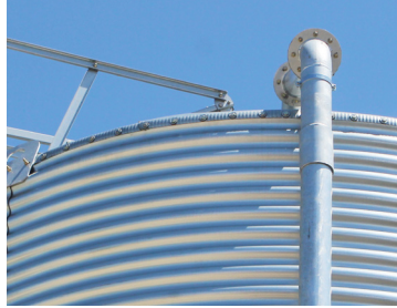
PNEUMOTÄITMINE Galvaaniliselt kaetud Ø100mm toru puhuriga täitmiseks.
