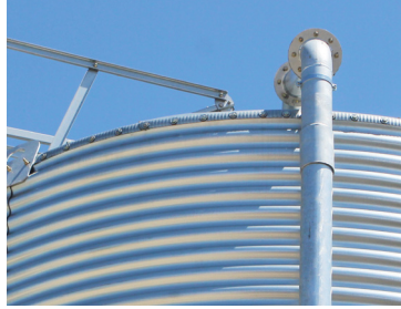
INNBLÅSINGSÅPNING Galvansiert rør Ø100mm for luftassistert fylling.
