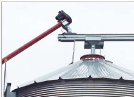
З'єднання шнекового транспортера з силосом (200/250мм)
