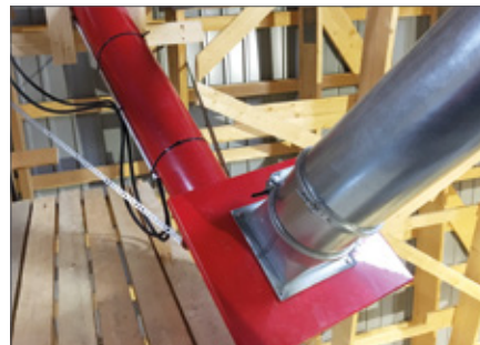
З'єднання силоса з металевим приймальним лотком транспортера (160/200мм)
